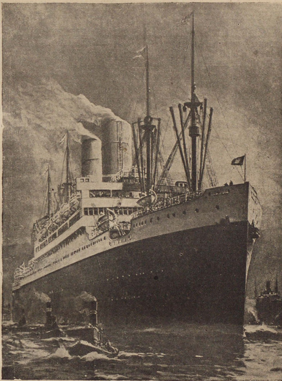
Только что спущенный пароход линии Гамбург—Америка „Альберт—Баллин“—с двумя турбинами, вместимостью в 22,000 тонн брутто и скоростью—15½ миль.
